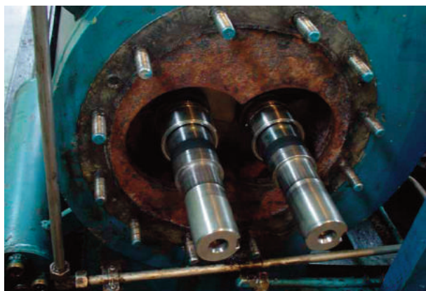
Торцовое уплотнение РК, мультифазный насос, газожидкостная смесь, нефтедобыча.
