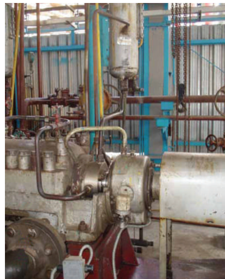
Торцовое уплотнение СД, насос НПС, газойль, 150°C, API Plan 52
